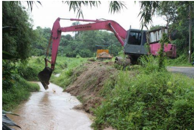
ภาพที่ 3 การปรับปรุงสภาพลำน้ำ เพื่อช่วยให้ น้ำสามารถไหลตามลำน้ำได้สะดวก
